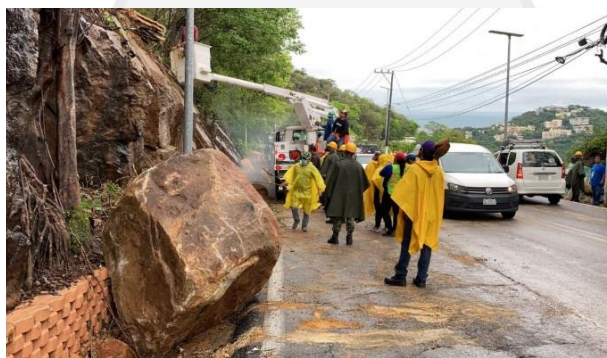
Imagen 6.- Imagen de periódico "El Sur" Caído de Rocas sobre carretera en Acapulco, Guerrero 2021.
