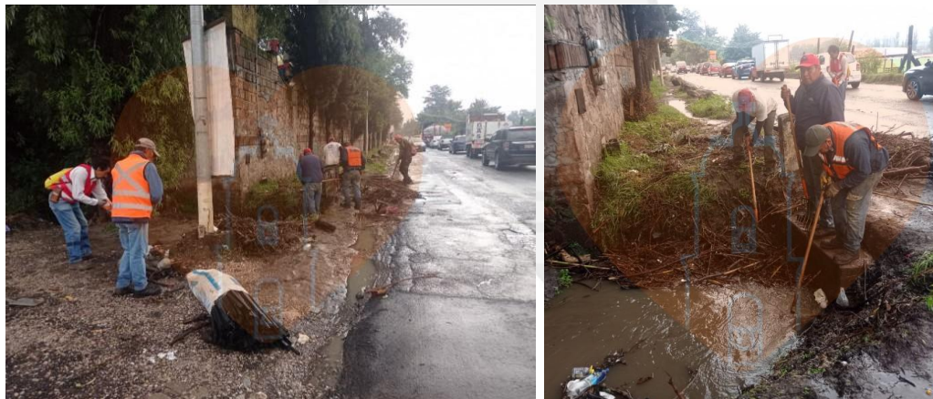
Imagen 28.- Imagen de obras de drenaje en Santa Cruz Tepetzotlán Estado de México 2025. Facebook
