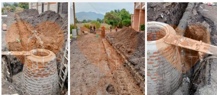
Imagen 29.- Imagen de obras de drenaje en Las Tablas San Mateo Xoloc, Tepotzotlán, Estado de México 2025. Facebook
