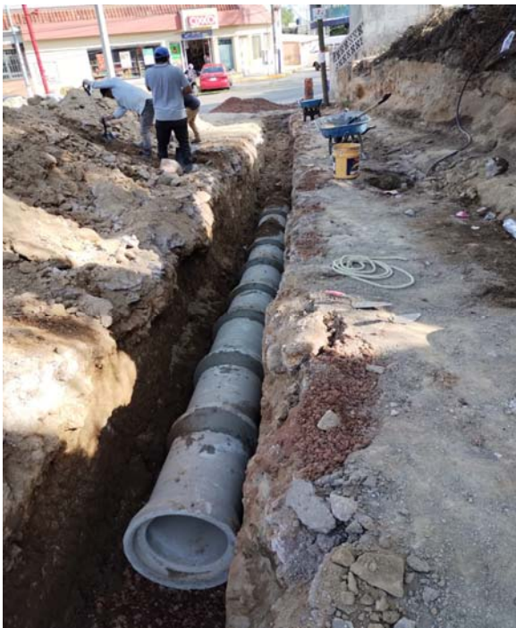
INTRODUCCIÓN DE DRENAJE CALLE JUAREZ NORTE Bo. CAPULA
