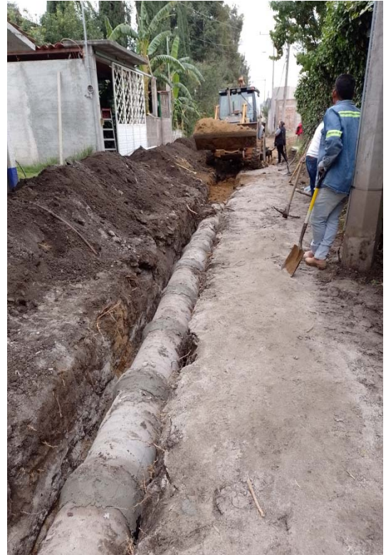
INTRODUCCIÓN DE DRENAJE CALLE TULIPANES
