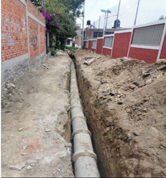
INTRODUCCIÓN DE DRENAJE CALLE MORELOS
