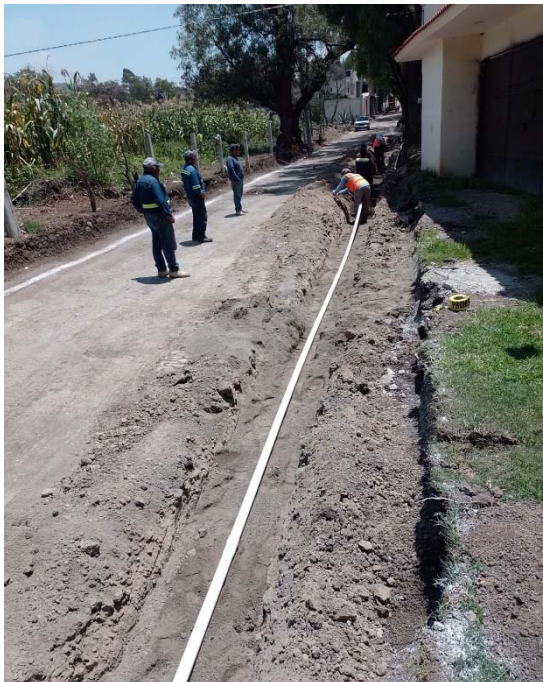
LÍNEA DE AGUA POTABLE CDA. FRANCISCO VILLA
