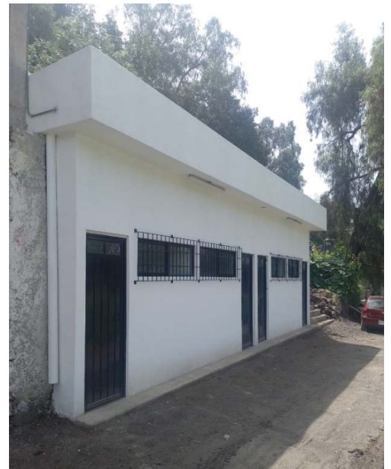
CONSTRUCCIÓN DE SANITARIOS Y VESTIDORES Bo. LA CONCEPCIÓN
