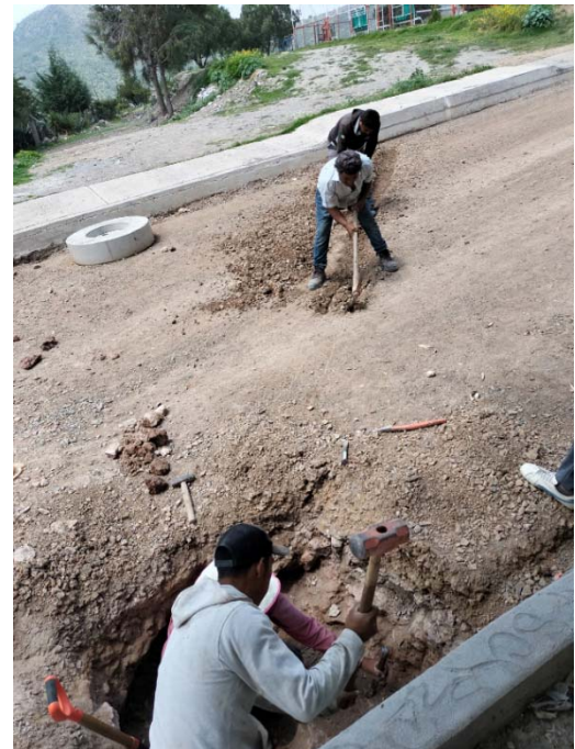
LÍNEA DE AGUA POTABLE CALLE PROLONGACIÓN JARAMILLO
