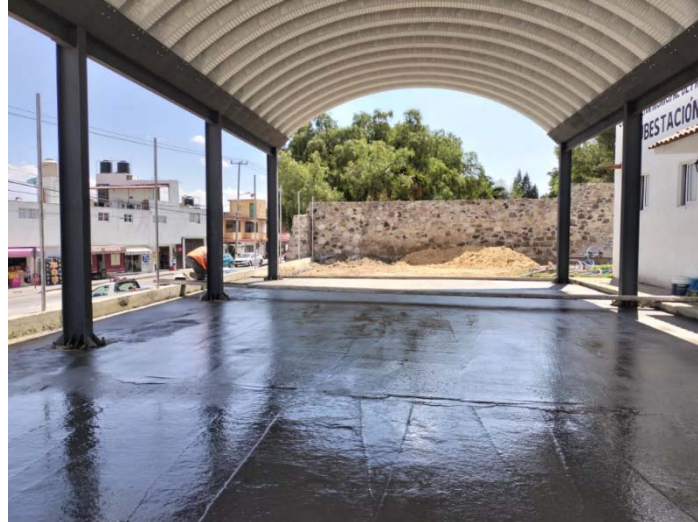
ARCOTECHO Y OBRA EXTERIOR SUB-ESTACION DE PROTECCION CIVIL
