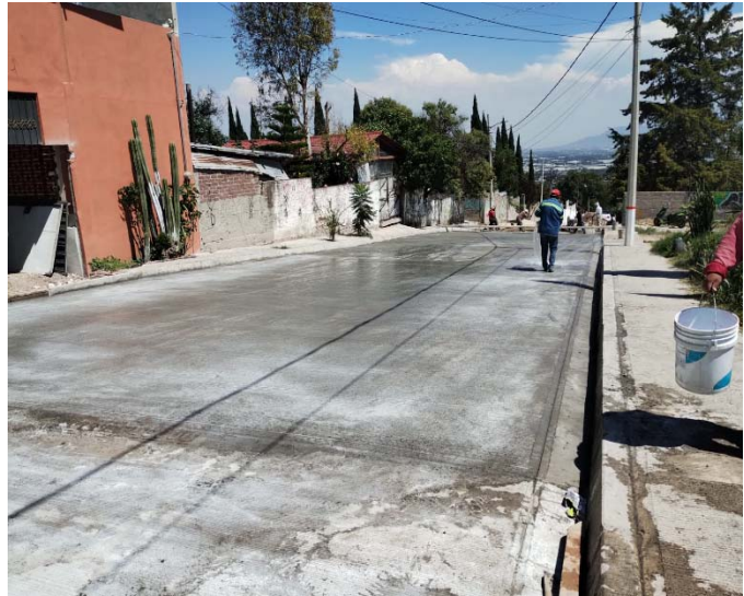
PAVIMENTACION CALLE PROLONGACION JARAMILLO
