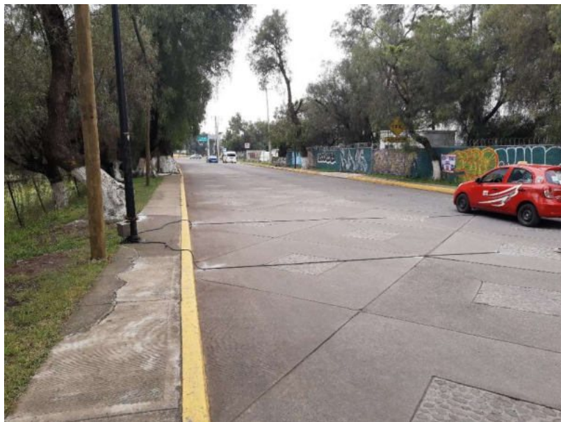
Foto 44. Vista de la Estación 22: Av. del Trabajo (Sur – Norte)
