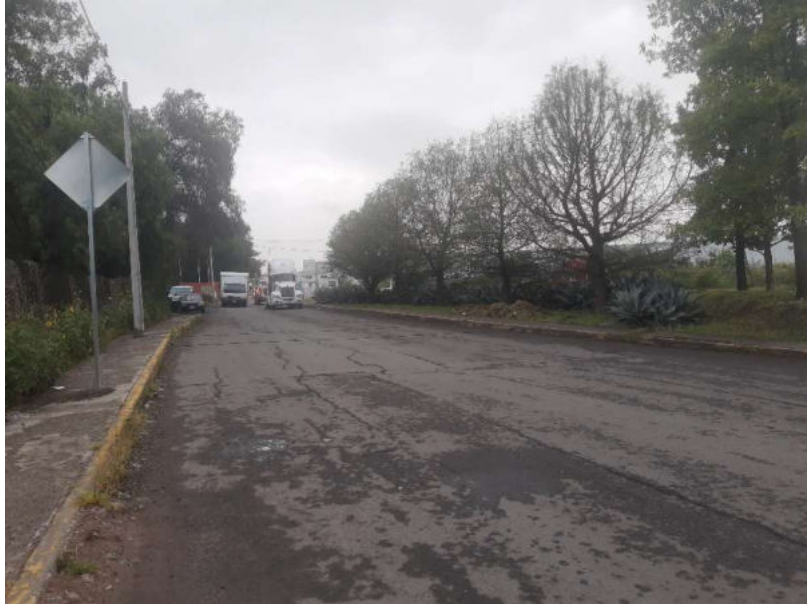
Foto 18. Vista de la Estación 09: Av. Circunvalación (Oriente - Poniente)
