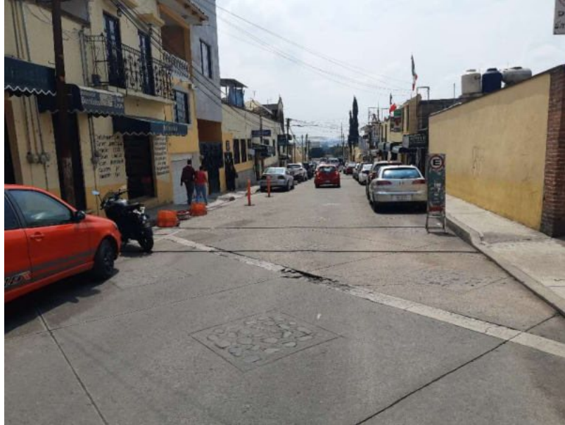
Foto 37. Vista de la Estación 19: Calle Adolfo López Mateos (Norte – Sur)
