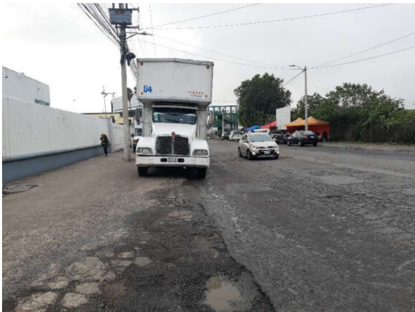
Foto 22. Vista de la Estación 11: Av. Del Convento (Sur – Norte)
