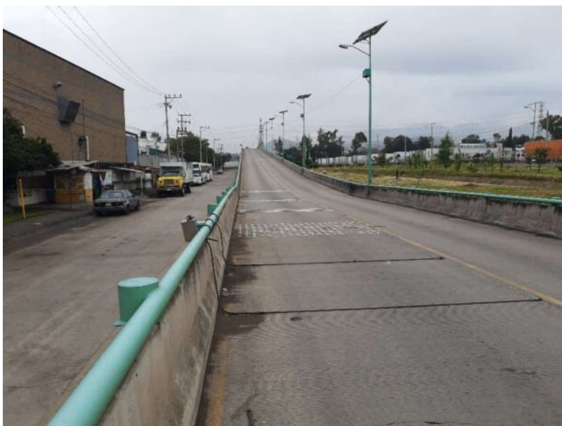
Foto 30. Vista de la Estación 15: PIV Tlacateco (Poniente – Oriente)
