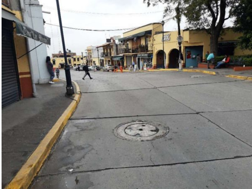
Foto 41. Vista de la Estación 21: Av. Eva Sámano de López Mateos (Sur – Norte)
