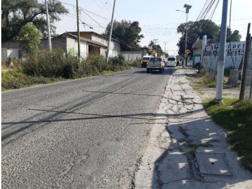
Foto 33. Vista de la Estación 17: Av. Insurgentes Poniente (Poniente – Oriente)
