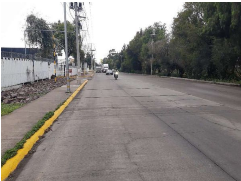
Foto 26. Vista de la Estación 13: Av. De La Industria (Sur – Norte)
