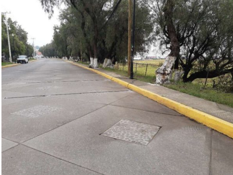
Foto 43. Vista de la Estación 22: Av. del Trabajo (Sur – Norte)
