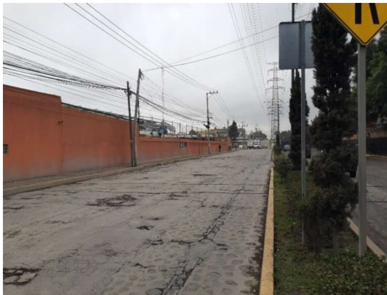
Foto 16. Vista de la Estación 08: Libramiento Norte Lado Sur (Sur – Norte)
