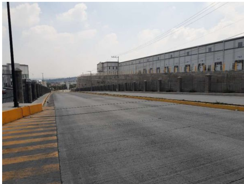
Foto 48. Vista de la Estación 24: Libramiento Norte Lado Norte (Sur – Norte)
