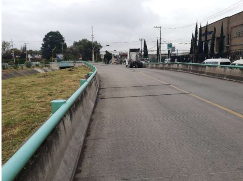
Foto 31. Vista de la Estación 16: PIV Tlacateco (Oriente – Poniente)
