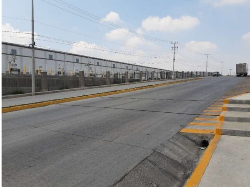
Foto 47. Vista de la Estación 24: Libramiento Norte Lado Norte (Sur – Norte)
