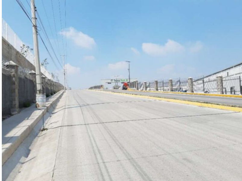
Foto 50. Vista de la Estación 25: Libramiento Norte Lado Norte (Norte – Sur)
