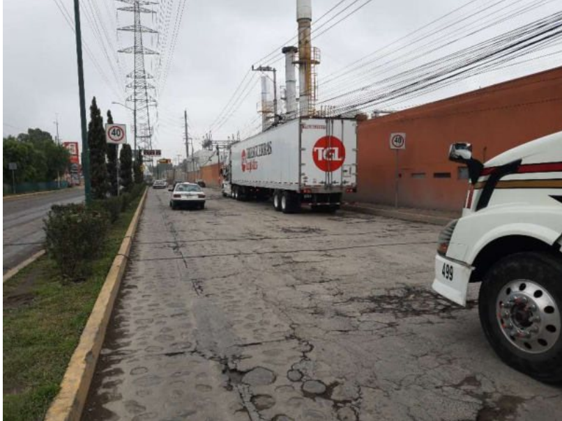
Foto 15. Vista de la Estación 08: Libramiento Norte Lado Sur (Sur – Norte)
