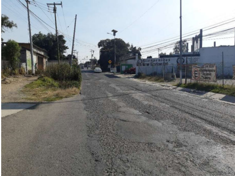
Foto 34. Vista de la Estación 17: Av. Insurgentes Poniente (Poniente – Oriente)
