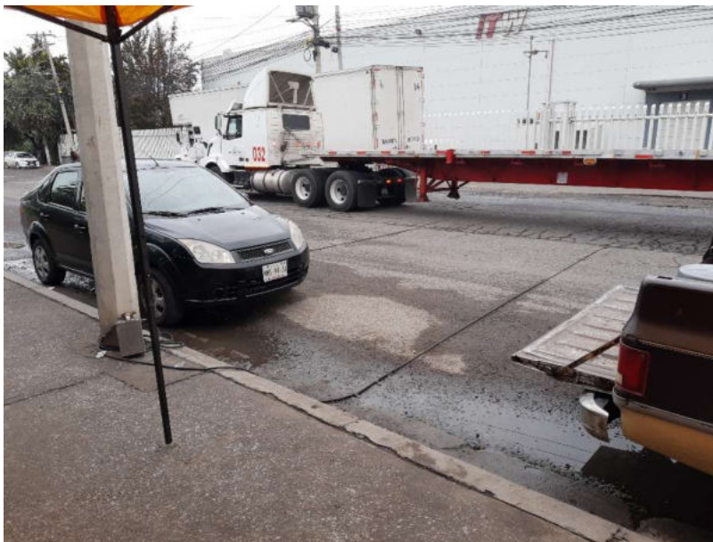
Foto 24. Vista de la Estación 12: Av. Del Convento (Norte – Sur)
