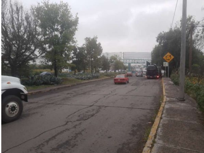
Foto 17. Vista de la Estación 09: Av. Circunvalación (Oriente - Poniente)
