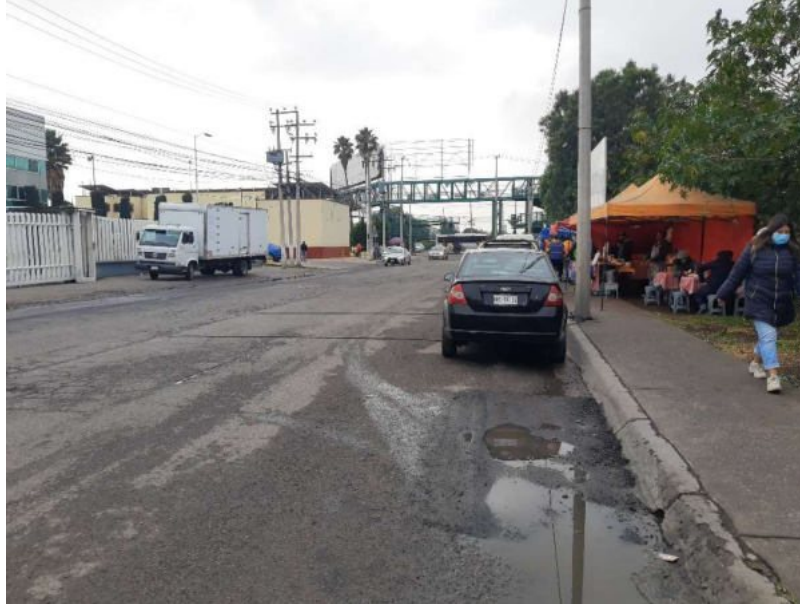
Foto 23. Vista de la Estación 12: Av. Del Convento (Norte – Sur)
